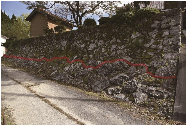
浄土寺の石垣（赤いラインの上下で積み方が違ってきます）
